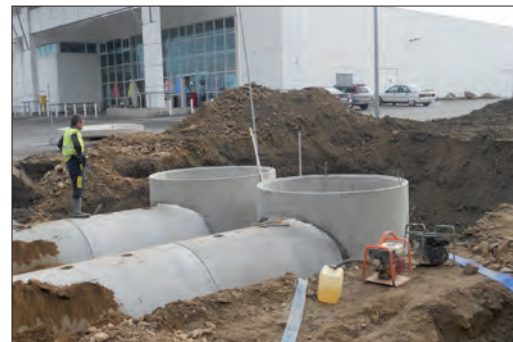
Installation dans le Grand Ouest d'un système de récupération d'eau de pluie pour le magasin Bricomarché de Batz-sur-Mer
